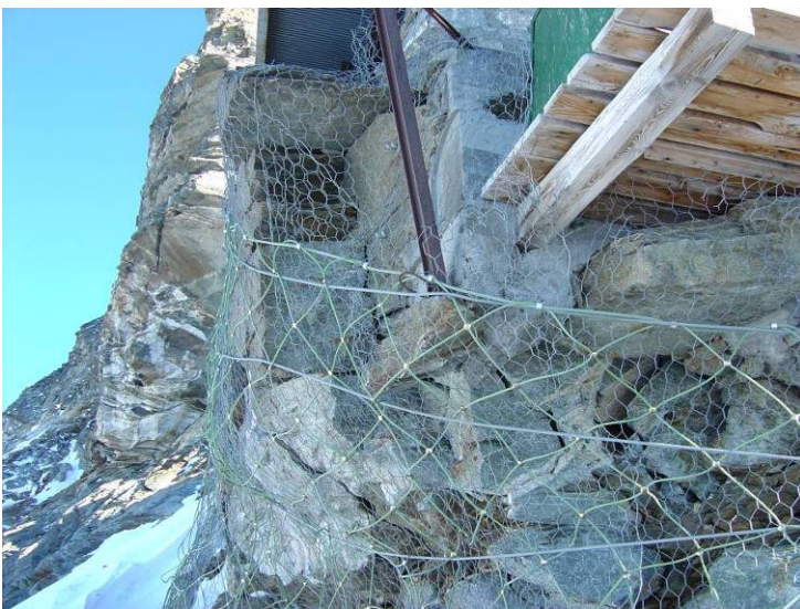
Figura 2 - Particolare dei lavori di consolidamento dell'ammasso roccioso su cui poggia la Capanna Carrel, resi necessari a seguito del rilascio tensionale dell'ammasso stesso occorso a seguito dell'anomala ondata di calore dell'estate 2003.
