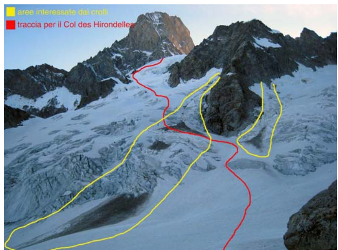
Figura 6 – Crollo di roccia avvenuto nell'estate 2007 lungo la salita al Col des Hirondelles, ripreso dal Rifugio Gervasutti (Foto M. Giglio).
